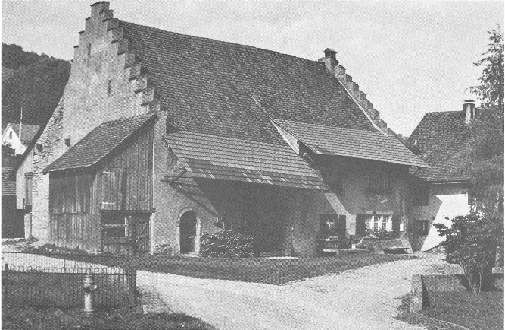
Zehntenscheuer. Hochstudbau aus dem 17. Jahrhundert (1688/1690), so benannt nach der alemannischen Bauweise. Die Besonderheit dieser Dachkonstruktion besteht darin, dass die damaligen Baumeister den Firstbalken auf mächtige Pfosten abstützten, welche vom Boden bis zum Giebel reichten.
