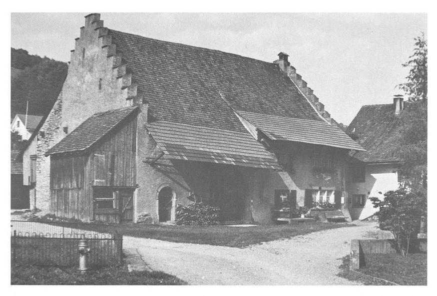
Zehntenscheuer. Hochstudbau aus dem 17. Jahrhundert (1688/1690), so benannt nach der alemannischen Bauweise. Die Besonderheit dieser Dachkonstruktion besteht darin, dass die damaligen Baumeister den Firstbalken auf mächtige Pfosten abstützten, welche vom Boden bis zum Giebel reichten.
