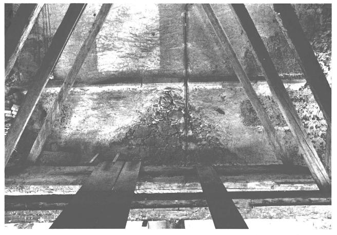
Giebelansatz der Kirche III am Turm, verputzte Turmwand und Anschluss des Verputzes an die Tuff-Eckquadern des Turmes.
