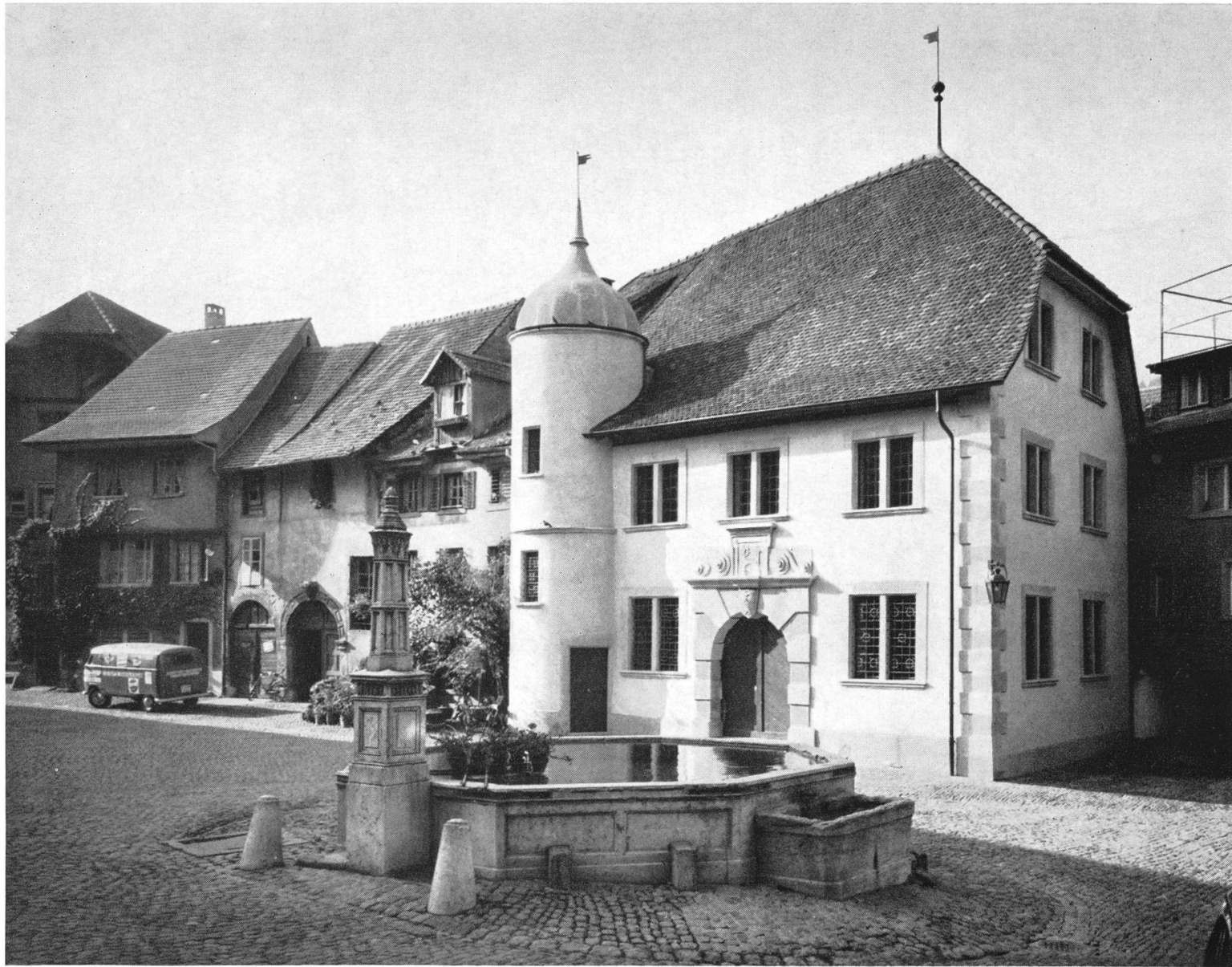
Brugg. — Zeughaus (Heimatmuseum) nach der Restauration
