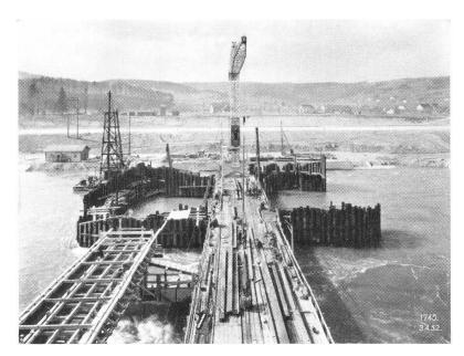
Hilfswehr, Baugrubenumschliessung der Wehröffnung 2 3. April 1952
