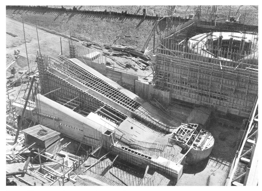
Kraftwerk Wildegg-Brugg. – Maschinenhaus, Schalung des Turbinenauslaufes 23. August 1950
