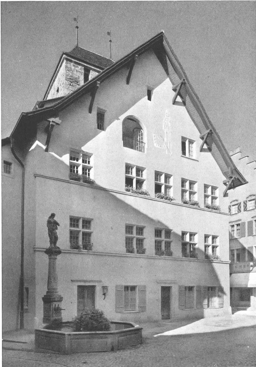
Brugg. Rathaus nach der Renovation 1950/51
