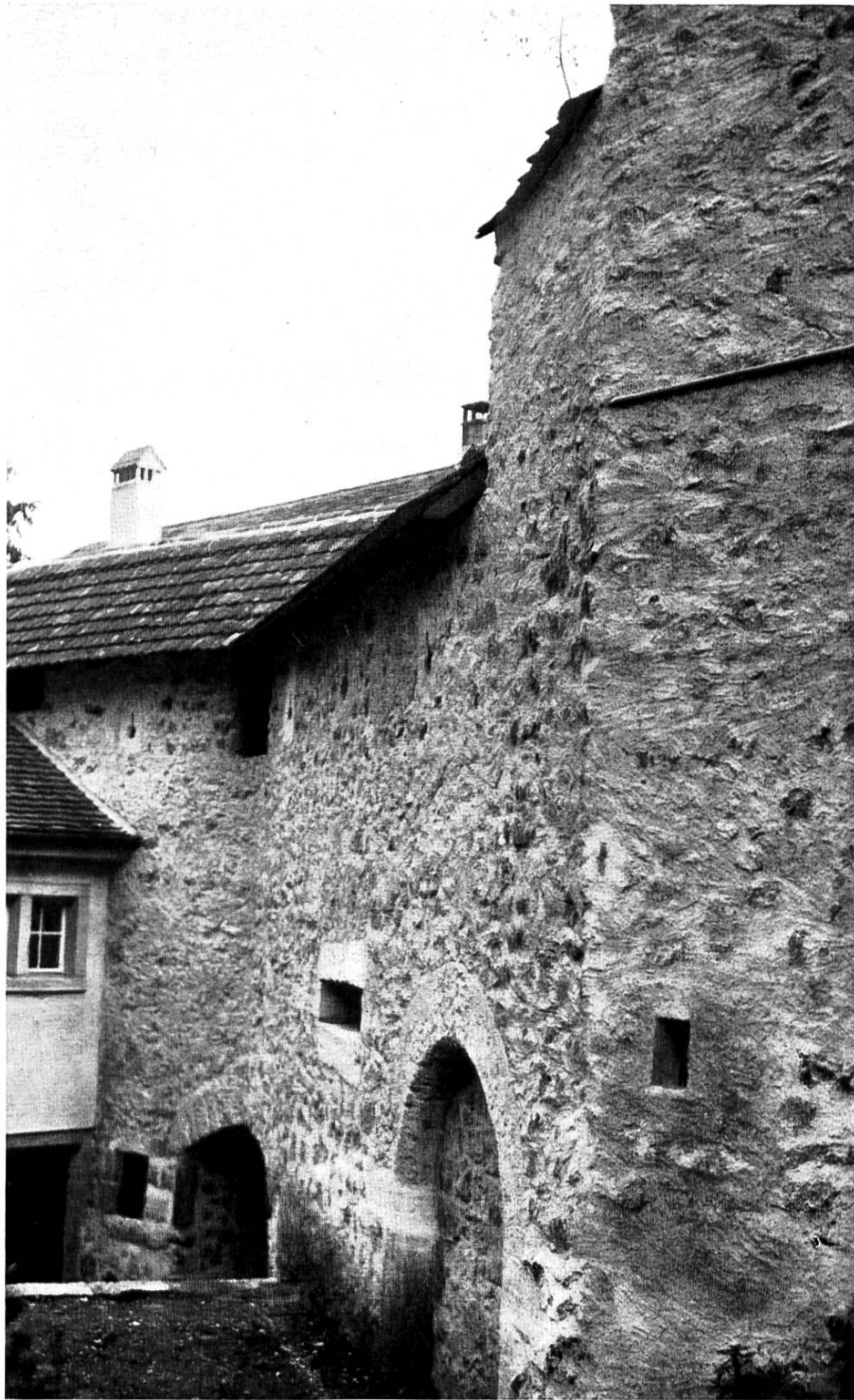
Brugg. Vorstadtwehrmauer mit vermauertem Steigtörli. Nach der Renovation 1949.
