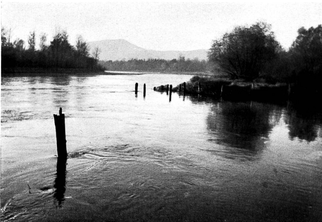
Vom Strom zerstörtes, altes Uferwehr zwischen Umiken und Willnachern.
