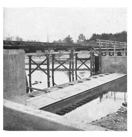
Abb. 7 Fertige Wehröffnung 1 Stauklappen gesenkt
