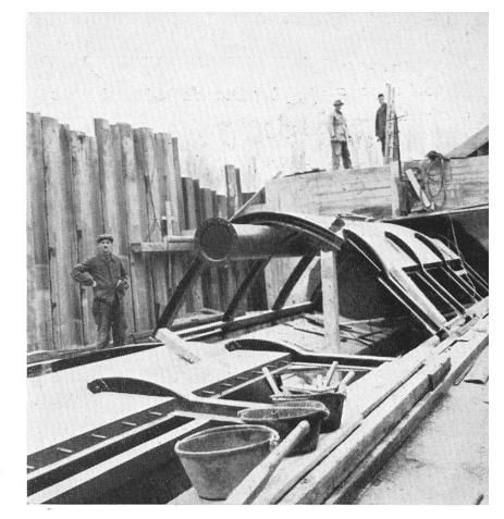
Abb. 6 Montage der Stauklappen
