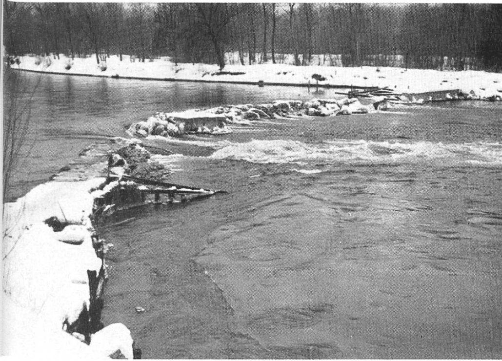
Abb. 1. Das alte Wehr am Einlauf zum Oberwasser-Kanal
