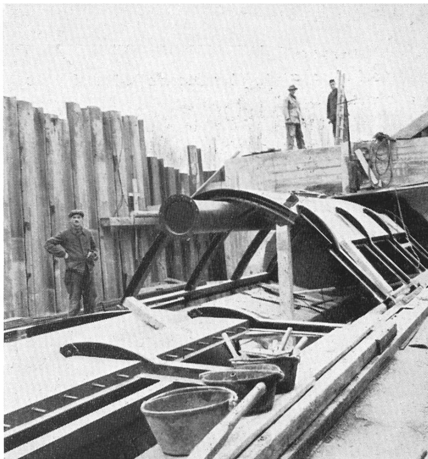
Abb. 6 Montage der Stau- klappen
