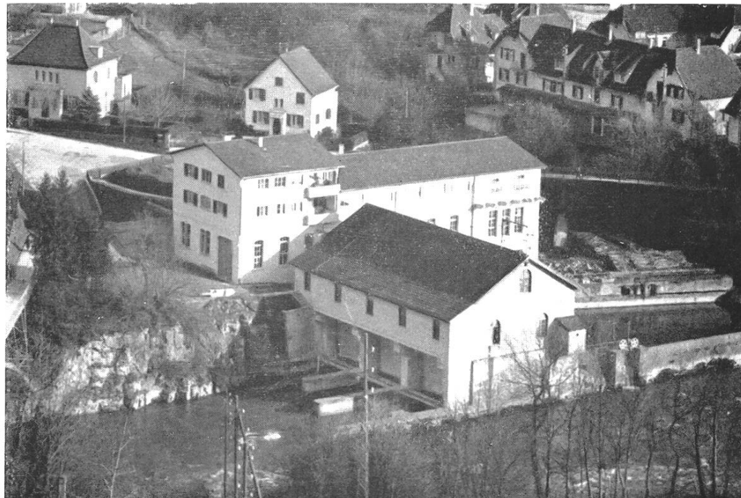
Nach dem Umbau 1940
