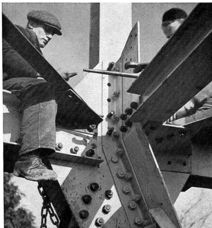
Arbeiter verschrauben einen Knoten am Schwebebahnturm der Landesausstellung
