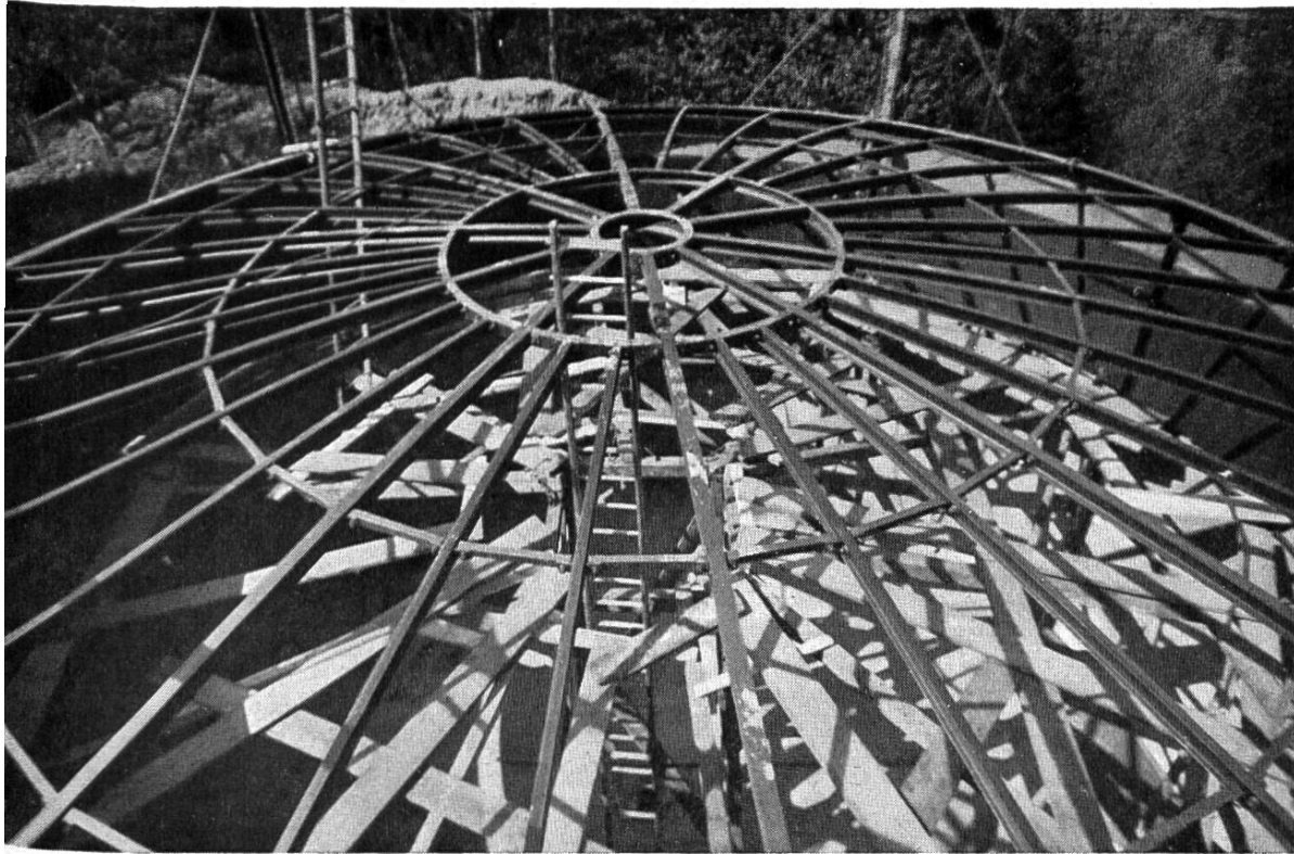
Stahlstelett eines Gasbehälters
