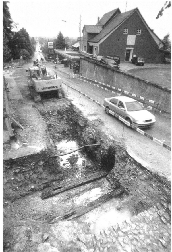
Fig. 13. Avenches/Route de Lausanne, porte de Payerne. Vue des fouilles depuis l'est. Au centre, deux des solives du pont du premier système défensif; au premier plan, l'un des murs de la porte; à l'arrière-plan, la place du Montmezard.
