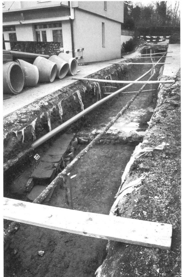
Fig. 3. Avenches/Impasse Marc-Aurèle. Vue des travaux depuis le sud. Au centre de l'image, recoupé par une canalisation de tegulae , les restes de l'un des murs de la galerie de péribole arrière du sanctuaire de la Grange des Dîmes et du temple rond.
