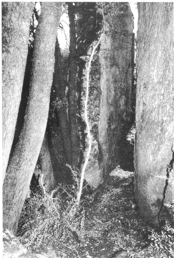
Fig. 41. Photo de l'entaille de 13 m dans la roche calcaire à Savanac-Cuzoul, sur le tracé de l'aqueduc de Cahors.
