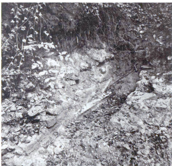
Fig. 11a. Photo de l'aqueduc de Bonne Fontaine au point BF.7.
