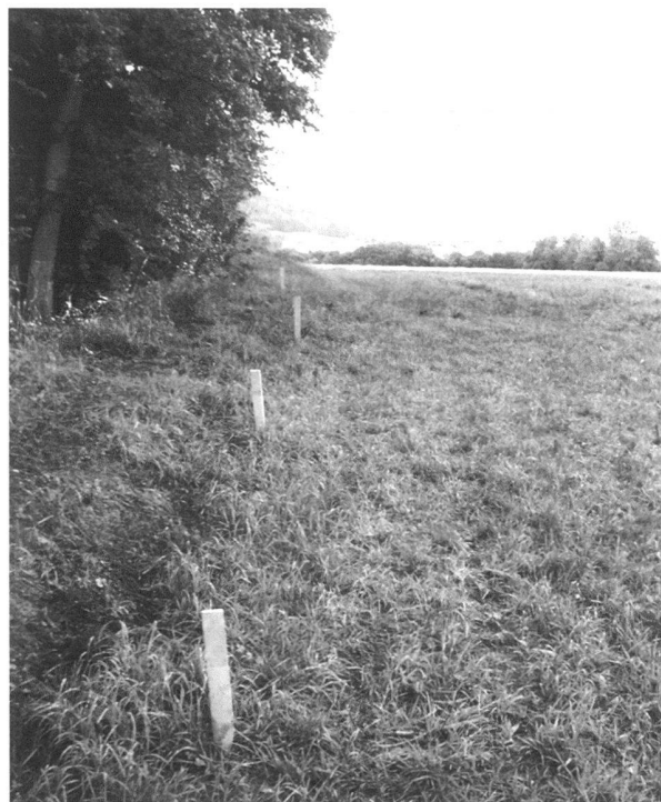
Fig. 2. Piquetage du tracé de l'aqueduc de Bonne Fontaine à proximité du Creux de la Chetta.
