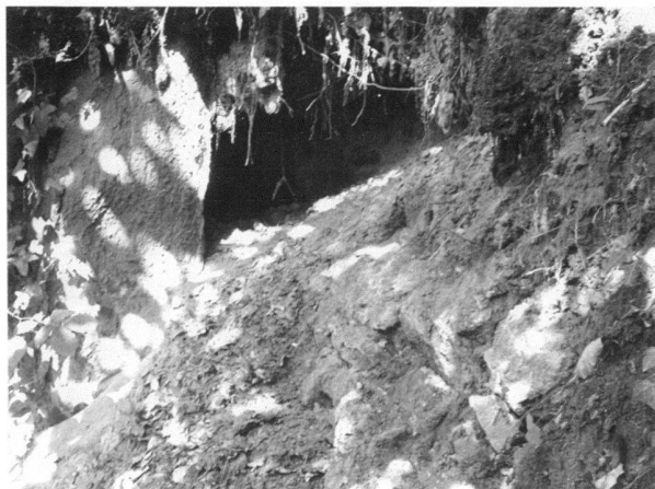
Fig. 22. Photo de la tranchée dans la molasse avec la voûte de l'aqueduc de Coppet au point C.8.
