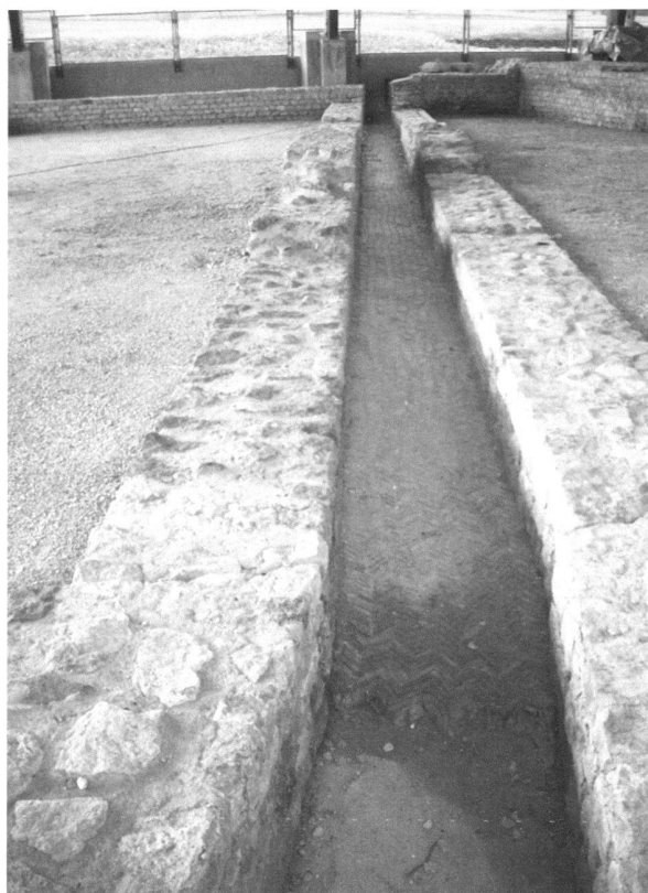
Fig. 30. Photo du canal de l'aqueduc du Bois de Châtel 1 avec son fond en opus spicatum, traversant le frigidarium des thermes d'En Perruet, vue amont.
