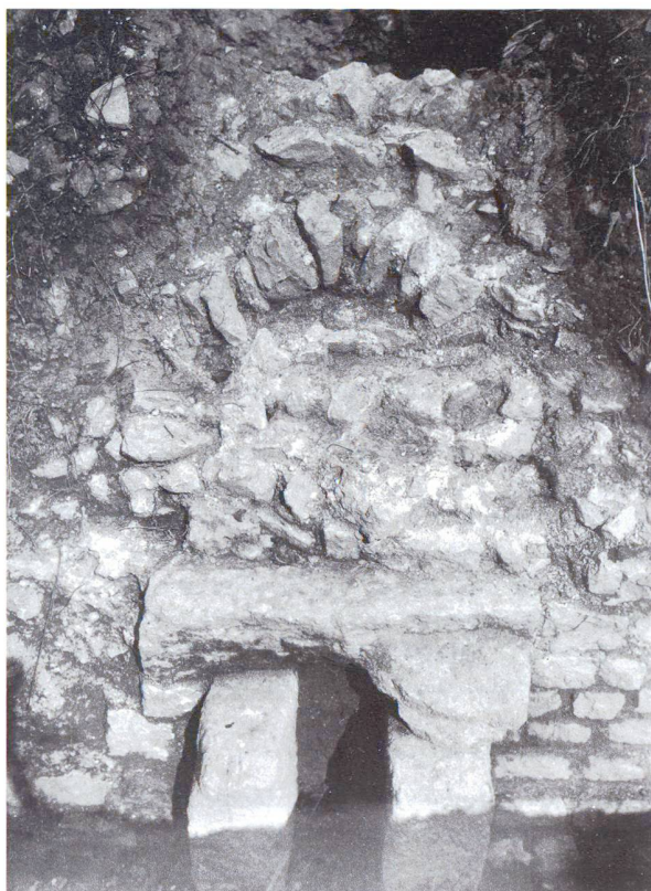
Fig. 31a. Photo de l'aqueduc du Bois de Châtel 3 traversant le rempart au point BC3.1.
