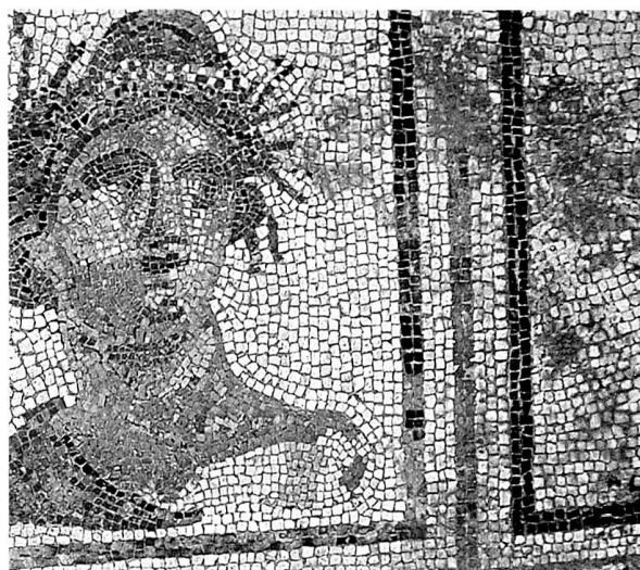
Fig. 13a. Orbe-Boscéaz. Travaux de conservation-restauration de la mosaïque des Divinités. Avant l'intervention: rejointoiment ancien au ciment et imprégnation de la surface à la cire. Photo MRA.
