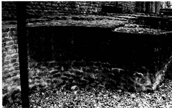
Fig. 10. La même alvéole après restauration en 2000. Photo MRA.
