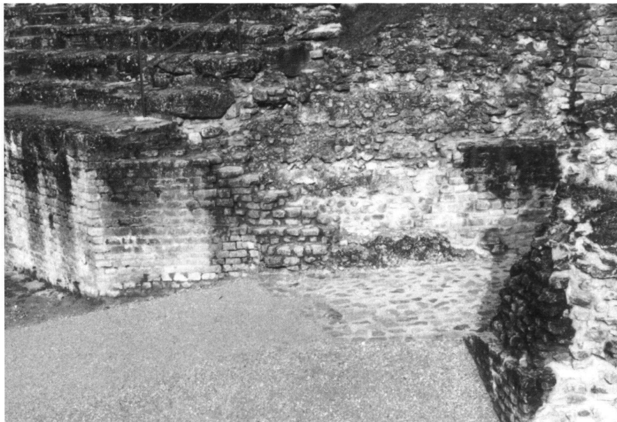
Fig. 17. Avenches, Amphithéâtre. Débouché actuel du passage nord dans l'arène. Les vestiges du massif supportant autrefois l'escalier menant à la base des gradins ont été restaurés pour situer l'emplacement de celui-ci.
