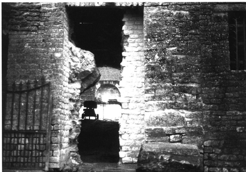
Fig. 42. Avenches/Amphithéâtre. Sondage au travers du bouchon obstruant l'entrée axiale Est. Vue vers l'arène et l'entrée Ouest.
