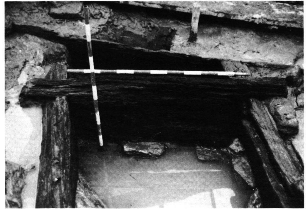
Fig. 12. Cuvelage du puits St.6: paroi Ouest.
