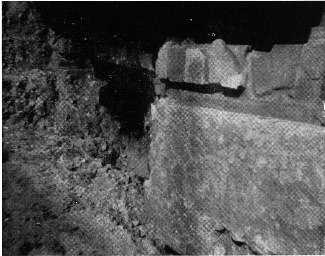
Fig. 33 — Mur transversal avec revêtement de briques, cheminée et rainure
