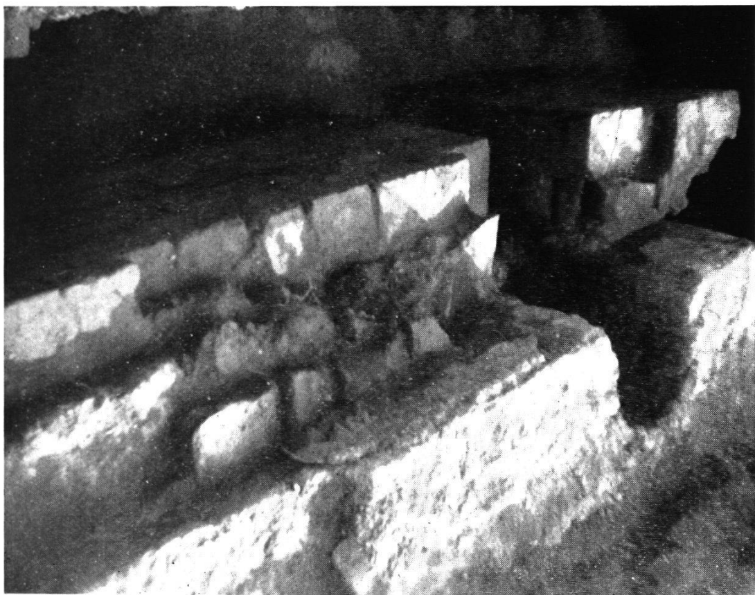
Fig. 31 — Cheminée ouverte dans le mur longitudinal N.-O.
