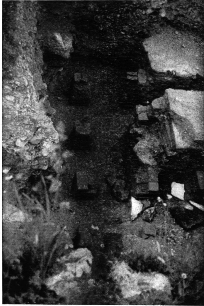
Fig. 20 — Débouché du canal de chaleur entre deux pilettes
