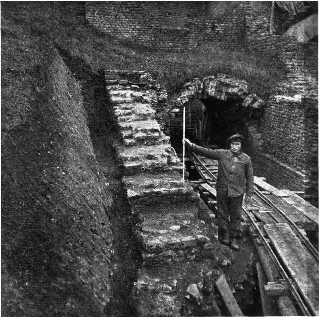
Passage nord de l'entrée orientale de l'Amphithéâtre vu de l'arène
