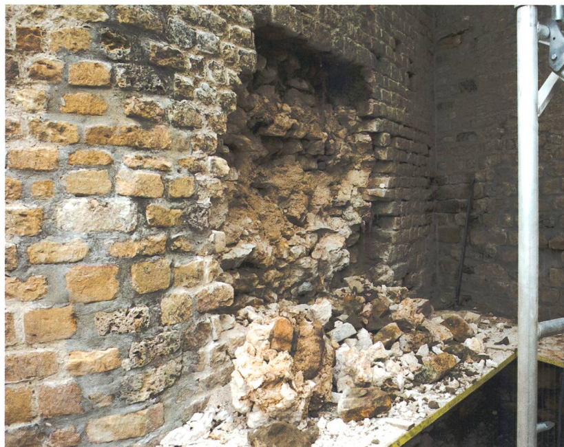
Abb. 20 Römische Stadtmauer, Bereich des Osttors. Durch Wasserfluss und Frost beschädigtes Schalenmauerwerk in der äusseren Schale des nördlichen Torturms des Osttors.
