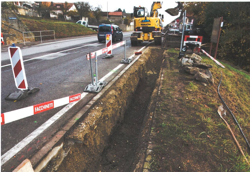
Fig. 73 2018.11. Route de contournement RC 601 Ouest. Vue du tronçon extra muros de la tranchée, à l'approche des vestiges visibles de la porte de l'Ouest.
