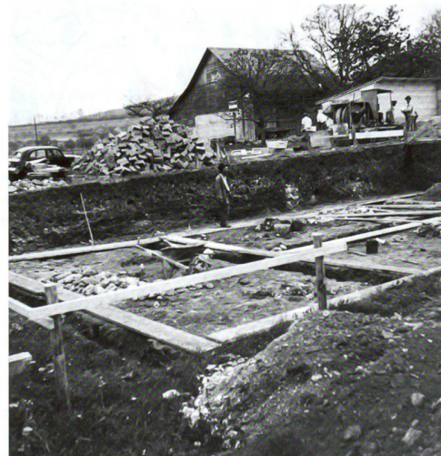
Fig. 5 1946.02. Insula 15. Photographie montrant le terrassement de la parcelle, au fond duquel affleurent des murs maçonnés.
