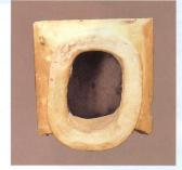
Catelle de corps: face visible moulée et corps d'ancrage perpendiculaire en col, ouvert sur le foyer. Ce corps est rempli de pierres ou de galets, puis entouré d'argile, de manière à emmagasiner, puis restituer peu à peu le rayonnement de la chaleur.
