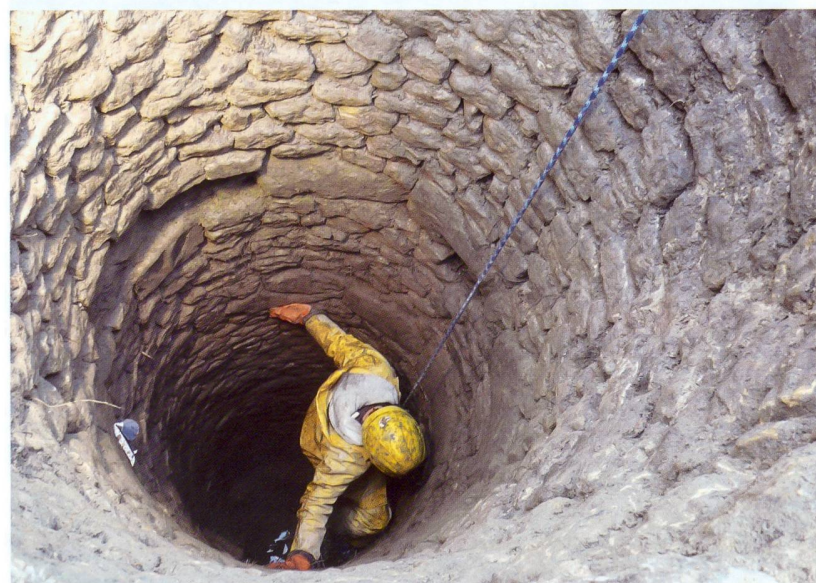
Fig. 5 Vue de l'intérieur du puits. Les assises de gros blocs de molasse ou de grès, qui s'échelonnent environ tous les mètres entre les assises de moellons de calcaire jaune, sont bien visibles.
