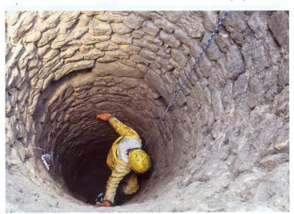
du puits (St 1) dont l'ouverture atteint 1,20 m de diamètre. Large de 70 cm, le second mur (M 2) est moins profondément fondé (env. 60 cm): courant à 1,40 m de la margelle du puits, il servait peut-être à délimiter une petite plateforme destinée aux usagers, abritée ou non par une toiture.
