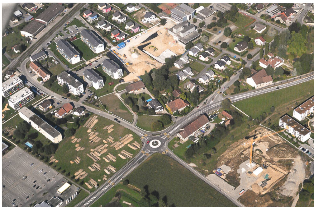
Fig. 1 Vue aérienne des chantiers en cours dans les quartiers ouest d'Avenches.
