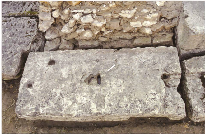
Abb. 18 (links) Theater. Quader der Werksteinfassade von M48, zum Gewände des Gewölbebogens am Übergang vom offenen zum überwölbten Abschnitt des Aditus gehörend. Deutlich ist erkennbar, wie sich der Quader zusammen mit dem rechts anschliessenden Block leicht nach Nordwesten verschoben hat.
