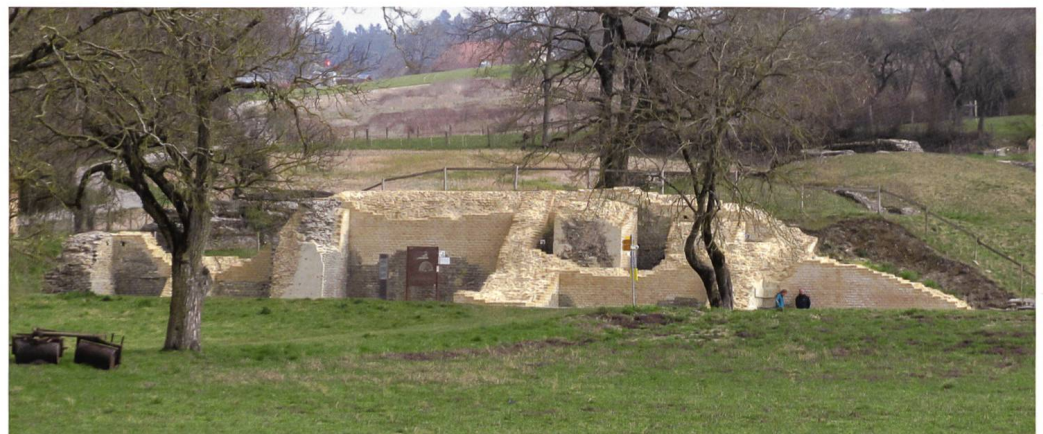
Abb. 20 Theater. Die 2015 restaurierte nordöstliche Abschlusszone mit der noch bis zu 6,00 m hoch erhaltenen Caveabschlussmauer und den bereits während der Bauzeit des Theaters zur Verstärkung in vomitorium 0 eingesetzten Mauerklötzen M55-M57.
