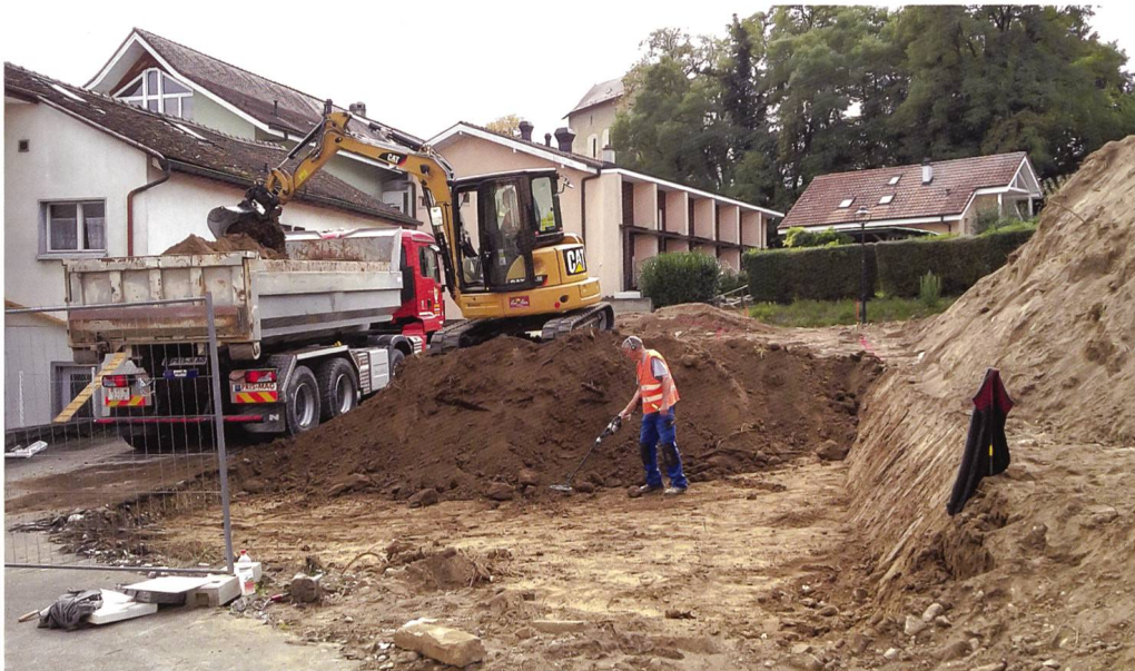
Fig. 100 2015.09 Temple de Derrière la Tour. Le suivi des terrassements en cours.
