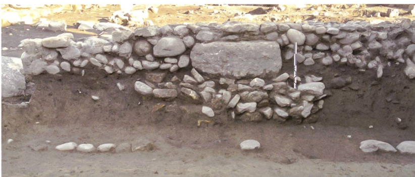
Fig. 35 2014.01. Route du Faubourg. Les deux états de la façade de l'«ensemble» occidental. Le bloc de grès St 310 est fondé sur un épais radier de fragments de calcaire jaune. Il est scellé par le mur maçonné (M 8).
