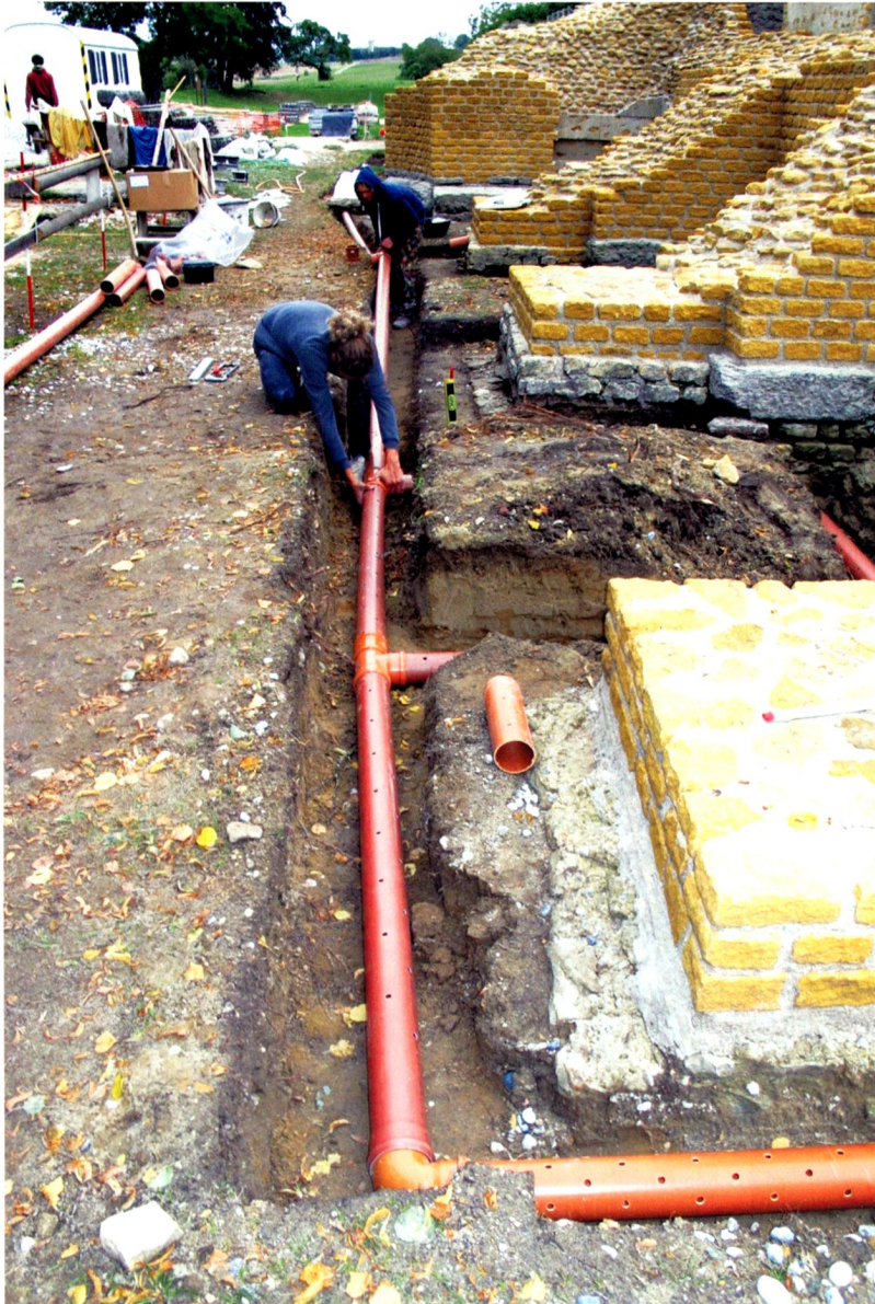
Fig. 30 Theater. Südwesthalle, Restaurierung 2013. Sickerleitungen entlang der Mauern sorgen für ein Trockenhalten des Mauerfusses; um möglichst wenig potentielle stratigraphische Anschlüsse an das Mauerwerk zu zerstören, werden die Rohre in einem Abstand von 40-50 cm zu den Fundamenten verlegt. Blick von Südwesten.
