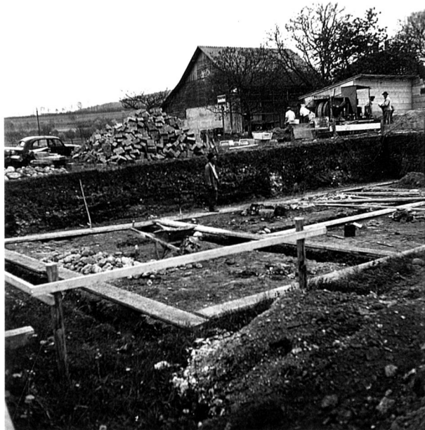
Fig. 29 (à g.) 1946.02. Insula 15. Avril 1946, fouille d'urgence engagée in extremis par Louis Bosset suite à l'apparition de vestiges au fond de l'excavation réalisée pour la construction du quatrième bâtiment locatif de la société industrielle Aventica SA.
