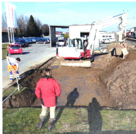
Fig. 8 2013.01. Chemin du Milieu 2. Travaux de décapages en cours.
