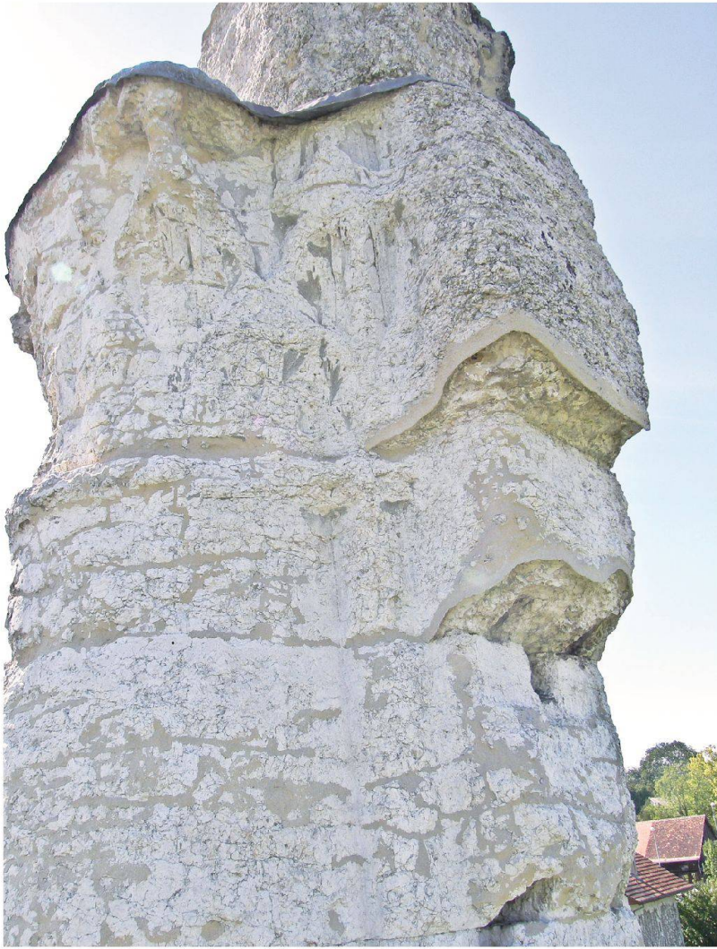
Fig. 8 Colonne du Cigognier. Photo réalisée en 2007, après les interventions de nettoyage. Cette figure illustre les différentes méthodes appliquées lors de la restauration des années septante pour soustraire l'édifice aux pénétrations d'eau et aux ruissellements: couverture en plomb, fermeture des joints entre assises, glacis, et larmiers.
