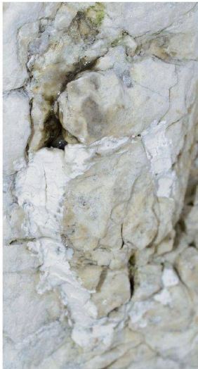
Fig. 17 (ci-dessus) Colonne du Cigognier. Injection de résine époxyde, retenue dans les fissures par un mortier provisoire.
