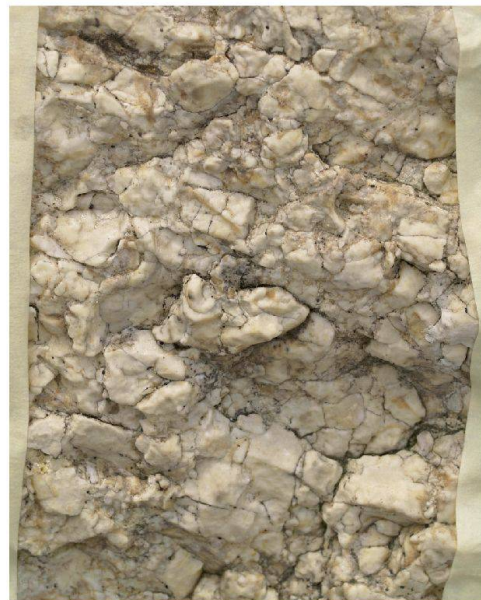
Fig. 19 Colonne du Cigognier. Protection de la surface contre l'infiltration d'eau pluviale, les risques de gel et la possibilité d'un développement de végétations par un mortier à la chaux. État avant et après son application.
