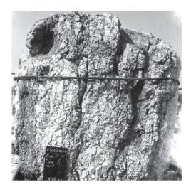
Pour contrôler la sécurité statique et observer la profondeur de la dégradation par les microfissures, quatre carottages de 5 cm de diamètre ont été forés, deux traversant de part en part dans les assises 14 et 12 et deux autres partiels, dans les assises 5 et 9. L'observation de ces forages a montré que la plus grande partie des fissures (0,5 à 1 mm) ont une profondeur de 1 à 3 cm seulement, mais que certaines, plus profondes, rendent une consolidation indispensable.
