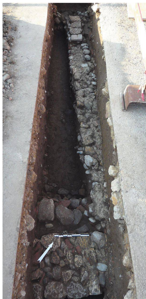
Fig. 14 2008.04. Route du Faubourg, tranchée 1. Les trois maçonneries délimitant une pièce à hypocauste découverte en amont de la chaussée menant au sommet de la colline.
