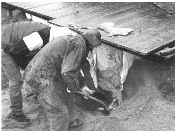
Fig. 26. Insula 19. Protection de vestiges à l'aide de géotextile et de sable. Photo MRA, laboratoire de conservation-restauration.
