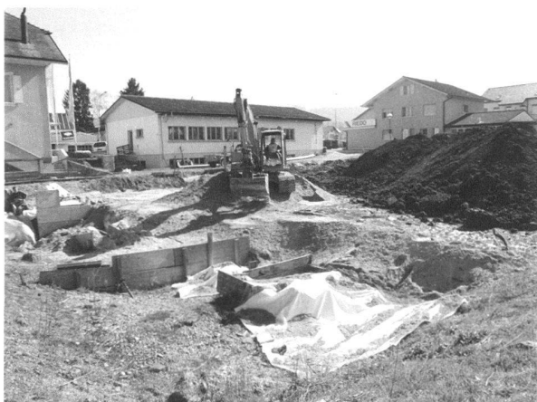
Fig. 27. Insula 19. Recouvrement des vestiges protégés. Photo MRA, laboratoire de conservation-restauration.
