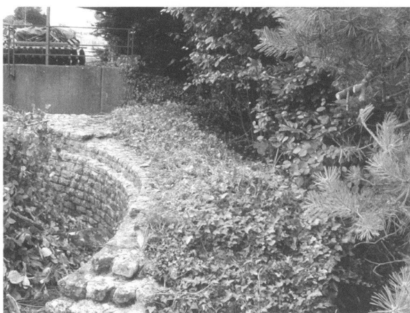
Fig. 7. Porte de l'Ouest. La maçonnerie de la tour nord dégagée des buissons qui l'envahissaient; la végétation tapissante est maintenue en protection du couronnement du mur (photo MRA).
