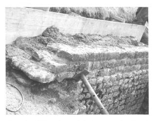
Fig. 4. Amphithéâtre. Le mur de fond de la cage d'escalier sudest, naguère rehaussé, a dû être réparé et doublé d'un arrière mur de béton pour résister à la poussée des terres de la cavea engazonnée (photo MRA).
