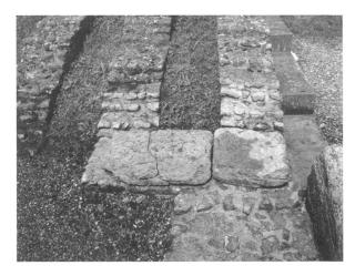
Fig. 6. Temple de la Grange des Dîmes. Murs d'échiffre de l'escalier avant et après nettoyage et colmatage des restaurations de la fin des années 1970 (photo MRA).
