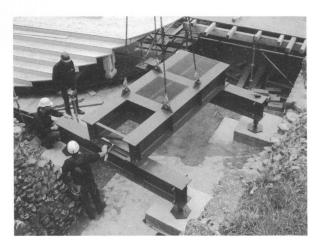
Fig. 12. Les imposantes fondations de la grue de chantier installée pour les représentations d'Aïda (photo MRA).
