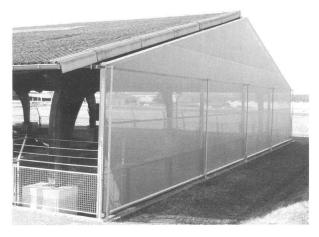
Fig. 1. Thermes de Perruet. Le filet de protection enroulable installé sur le côté oriental de l'abri (photo MRA).
