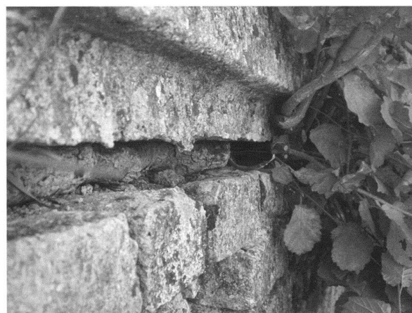
Fig. 11. Mur d'enceinte. Un exemple des dégâts causés par la croissance d'arbustes entre la dalle de couverture du mur et la maçonnerie de son parement (photo MRA).
