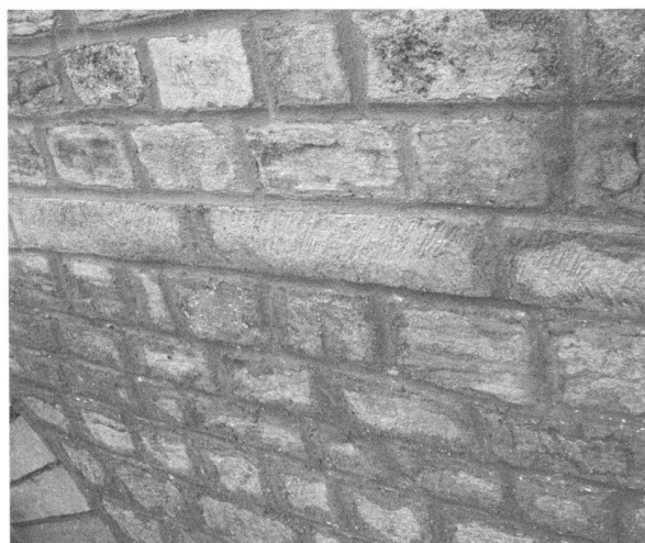
Fig. 8b. Mur d'enceinte. Détail du parement côté campagne après restauration (photo MRA).
