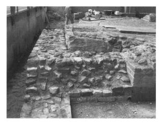
Fig. 4. Les Thermes de Perruet. Les murs du frigidarium délimitant l'angle du bassin, reconstruits à hauteur utile (photo MRA).
