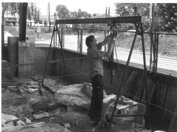
Fig. 3a. Les Thermes de Perruet. Remise en place des deux morceaux de l'angle du bassin sur des fondations modernes (photo MRA).
