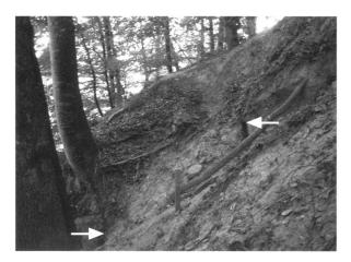
Fig. 14. Tranchée dans la molasse et son remblayage au point BF.P.74. Les limites visibles du creusement sont marquées par les flèches blanches.
