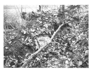
Fig. 19. Photo de l'arbre couché ayant emporté des claveaux de l'aqueduc de Coppet dans ses racines au point C.P.30.
