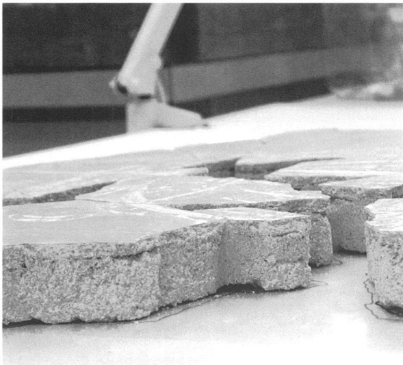
Fig. 9. Les mêmes fragments avec le nouveau mortier et avant leur montage sur le support. Photo MRA.
