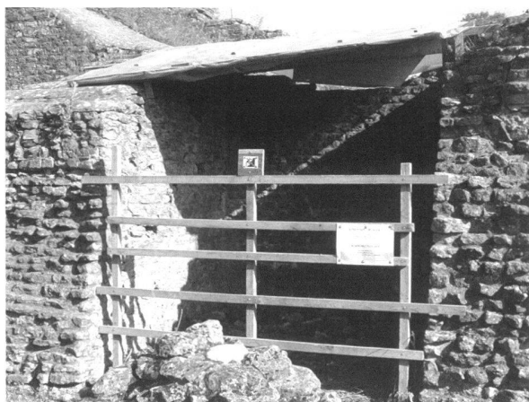
Fig. 4. Le Théâtre. Un secteur clôturé et protégé des intempéries: le parement du contrefort M 22, à gauche, s'est décollé et menace de s'effondrer (photo MRA).
