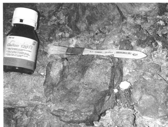
Fig. 8. A l'Amphithéâtre, traitement des racines résiduelles d'un buisson parasite des murs (photo MRA).
