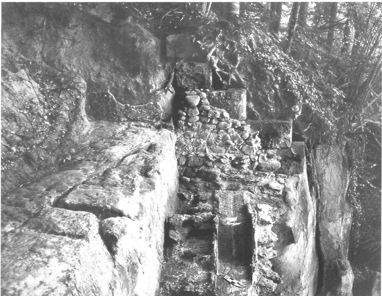
Fig. 33. Avenches/Pré Mermoud. Au centre de l'image, le canal de l'aqueduc de Coppet est mis en évidence par les concrétions calcaires encore présentes à l'intérieur de ses piédroits maçonnés.
