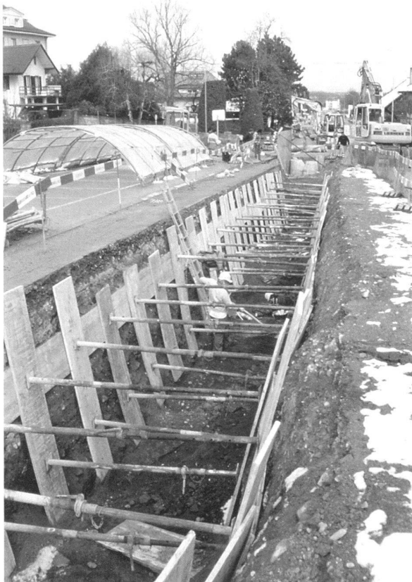
Fig. 3. Avenches/Avenue Jomini. Vue des travaux à la hauteur de l'EMS « Marc-Aurèle ». Quelques vestiges maçonnés sont visibles en fond de tranchée.
