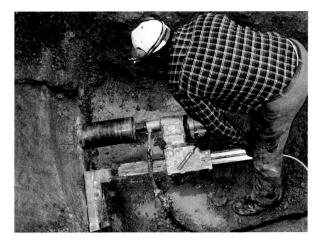
Fig. 7. Installation d'un drainage au travers du mur périmétral de l'amphithéâtre. Photo MRA.
