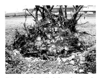
Fig. 5. Le Mur d'enceinte Vers la Gare, endommagé par la chute d'un arbre enraciné sur sa maçonnerie. Photo MRA.
