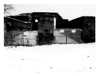
Fig. 6. La Porte de l'Est, dont on a dû condamner deux passages, suite à la dégradation des restaurations anciennes. Photo MRA.
