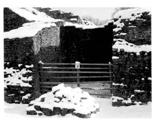
Fig. 2. Le Théâtre. Un secteur clôturé en raison des risques d'effondrement d'un parement anciennement restauré. Photo MRA.
