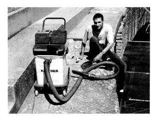
Fig. 8. Travaux de rejointoiement du dallage du mur de podium de l'amphithéâtre. Photo. MRA.
