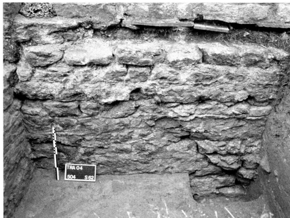
Fig. 33. Avenches/En Selley, théâtre. Sondage S 62. Joint de reprise en sous-œuvre du mur M 66.
