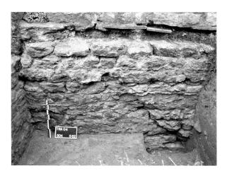
Fig. 33. Avenches/En Selley, théâtre. Sondage S 62. Joint de reprise en sous-œuvre du mur M 66.
