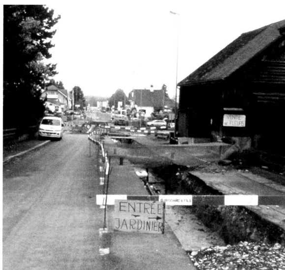
Fig. 12. Avenches/Avenue Jomini. L'avenue Jomini en chantier au début de l'automne 2004. L'ouverture des tranchées pour les conduites du chauffage à distance et du réseau d'eau communal a parfois posé des problèmes d'accès aux habitations riveraines.
