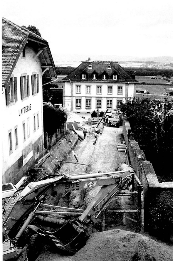
Fig. 15. Avenches/Haut de l'avenue Général Guisan. Certaines rues ont été éventrées sur toute leur largeur pour permettre la pose des différentes conduites. Vue du sud.
