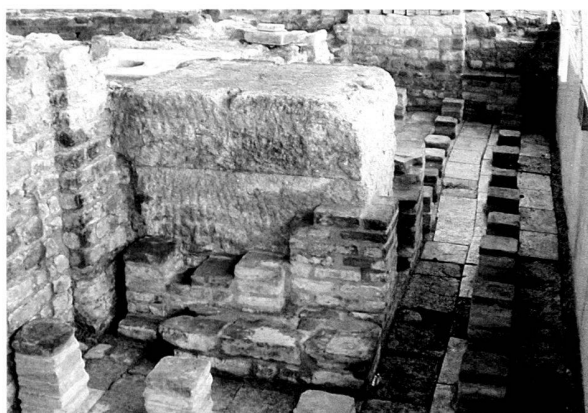
Fig. 3. Les Thermes de Perruet, caldarium. Fondation du pilier sud avec le muret de doublage calorifuge. Reconstruction au mortier de chaux teinté, imitant le mortier d'argile romain. Photo MRA.
