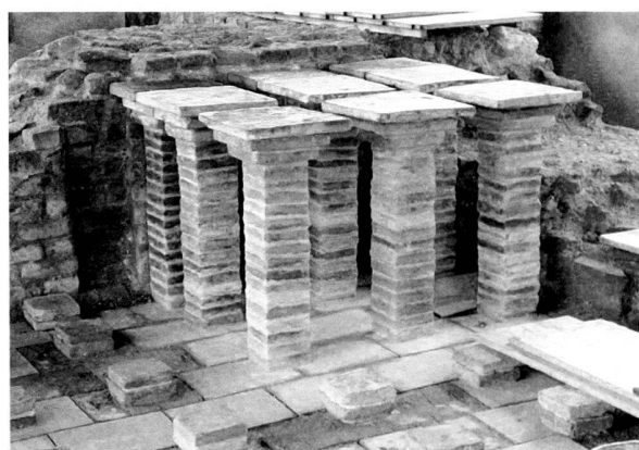
Fig. 4. Les Thermes de Perruet, tepidarium, angle nord-ouest. Première étape de reconstitution d'un secteur didactique présentant le système de chauffage romain par hypocauste. Photo MRA.
