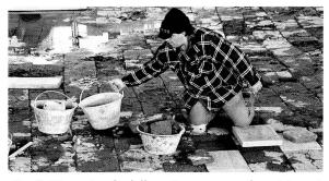
Fig. 6. Réparation du dallage. Pour conserver la position originale de chacun d'eux, c'est dalle par dalle qu'on prélève les éléments dégradés et qu'on pose les nouveaux sur un lit de gravier très fin. Photo MRA.
