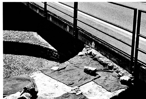
Fig. 12. Les travaux au mortier de chaux se font durant la belle saison. Pour éviter une dessiccation trop rapide par le soleil ou le vent, le mortier frais est protégé par des toiles de jute régulièrement arrosées. Photo MRA.
