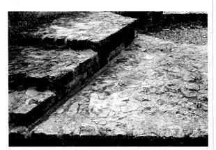
Fig. 10. La même chape après restauration. Une saignée a été pratiquée au pied du mur de gauche pour faciliter l'écoulement des eaux pluviales. Photo MRA.
