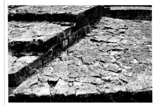
Fig. 9. Détail d'une chape de mur dégradée. Photo MRA.
