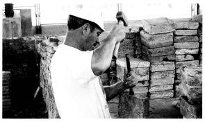
Fig. 7. Le mortier dur des années 1950 est enlevé avant remontage des pilettes, qui seront scellées par un mortier de chaux légèrement teinté. Photo MRA.
