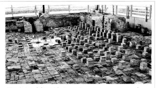
Fig. 4. Le sol du tepidarium. Etat au commencement des travaux. Au fond, une flaque d'eau due à la remontée périodique de la nappe phréatique. Avec les gels hivernaux, c'est l'un des facteurs principaux de la dégradation du monument. Photo MRA.
