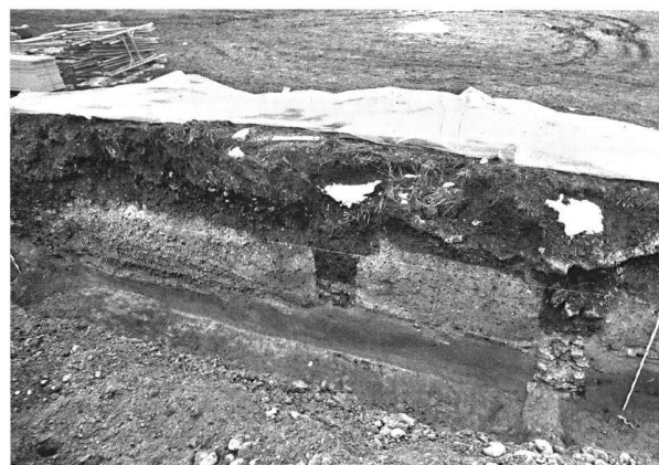
Fig. 56. Voirie insulae 12/18. Les chaussées du decumanus R 1 en coupe. A droite, le fantôme du mur de stylobate du portique L 59 (fig. 33 et 36). Etats 1-4 (I er -III e s. ap. J.-C.). Vue depuis le nord-est.
