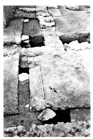
Fig. 27. Insula 12, 1986. Domus Est. Négatifs des cloisons à colombages séparant les pièces L 1 à 3 avec les dalles servant de support aux montants verticaux (fig. 18). Etat 2 (40/50-70/85 ap. J.-C.).
