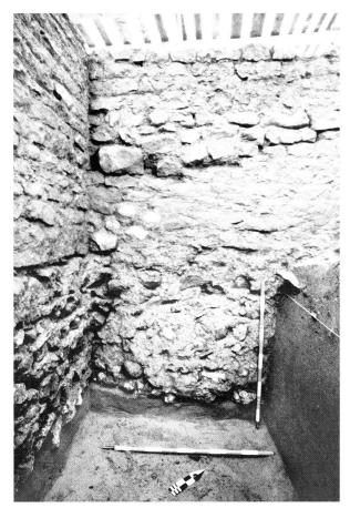
Fig. 50. Insula 18, 1986. Bâtiment riverain nord-est. Les impressionnantes fondations du local L 40\*, implantées à une profondeur de 2,60 m par rapport au sol de la pièce (fig. 36). Etat 3 (70-150). Vue depuis le sud.
