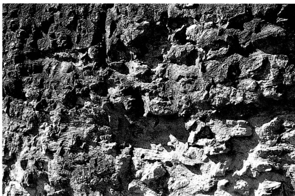
Fig. 5. Détail du mur du Rafour: aspect du noyau du mur avec un ancien mortier de consolidation. Photo MRA.
