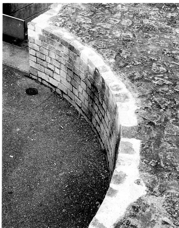
Fig. 8. La même alvéole après restauration en 2000. Photo MRA.
