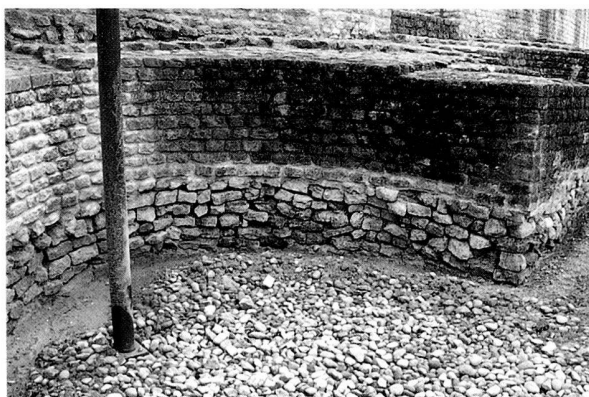
Fig. 9. Une alvéole du mur périmétral du secteur nord-est. La partie basse doit être rejointoyée. Photo MRA.
