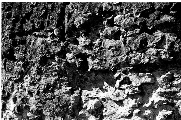
Fig. 5. Détail du mur du Rafour: aspect du noyau du mur avec un ancien mortier de consolidation. Photo MRA.
