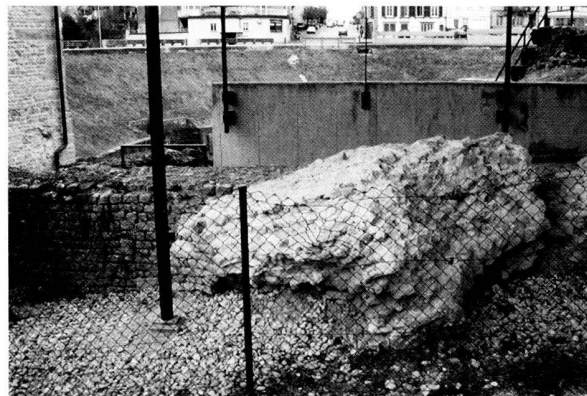
Fig. 11. L'alvéole nord-est du secteur non restauré a été stabilisée par un remblai de soutien. Photo MRA.
