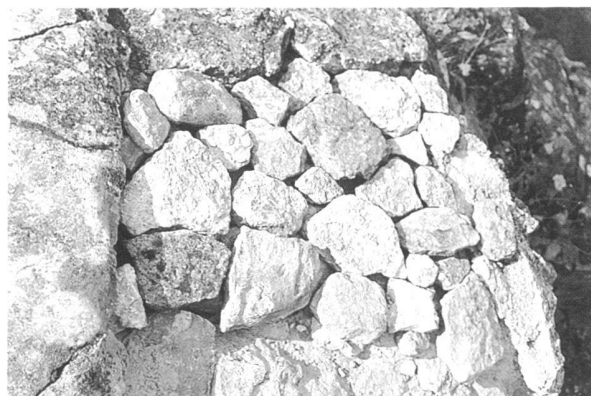
Fig. 6 et 7. Préparation d'une chape de protection. Pour remplacer une chape de ciment fissurée (en haut), on assemble à sec des pierres calcaires qui seront liées au mortier de chaux (en bas). De telles chapes évitent l'usure mécanique du noyau original due au passage des visiteurs et assurent une bonne protection contre les intempéries, pluie, neige ou exposition excessive au rayonnement solaire. Photo M. Kaufmann, MRA.
