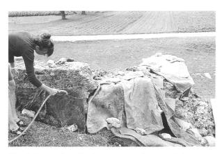
Fig. 5. Le mortier à la chaux ne «prend» que très lentement. Il doit rester longtemps humide, au moins au début du processus. Pour obtenir un mortier de bonne qualité, il convient de le «soigner» après la mise en oeuvre, en le compactant, le maintenant à l'ombre et lui assurant une humidité suffisante. Photo M. Kaufmann, MRA.
