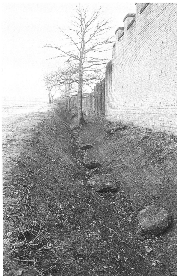
Fig. 8. Le fossé du mur d'enceinte au nord de la porte de l'Est, rétabli dans son profil original. Les chaperons tombés du sommet du mur restent à récupérer. Photo Ph. Bridel, FPA.
