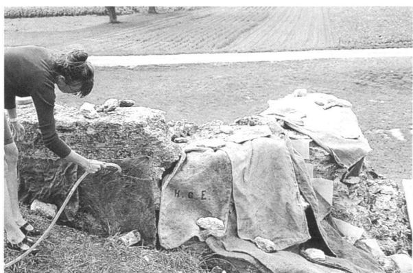
Fig. 5. Le mortier à la chaux ne « prend » que très lentement. Il doit rester longtemps humide, au moins au début du processus. Pour obtenir un mortier de bonne qualité, il convient de le « soigner » après la mise en oeuvre, en le compactant, le maintenant à l'ombre et lui assurant une humidité suffisante. Photo M. Kaufmann, MRA.
