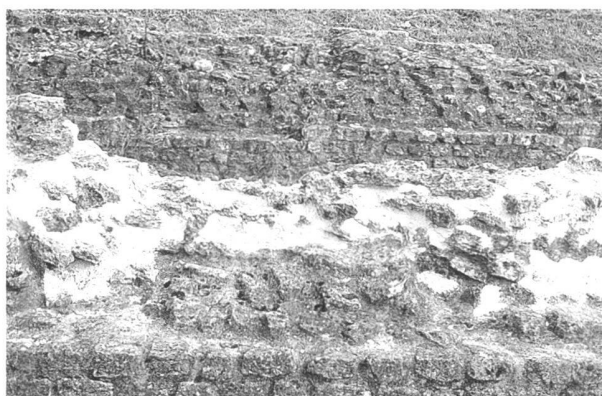
Fig. 4. Après restauration : pour assurer la conservation du noyau original, les secteurs endommagés doivent être consolidés en profondeur. Pour ce faire, on utilise un mortier à base de chaux, de pouzzolane, de tuileau et de sable. Photo M. Kaufmann, MRA.
