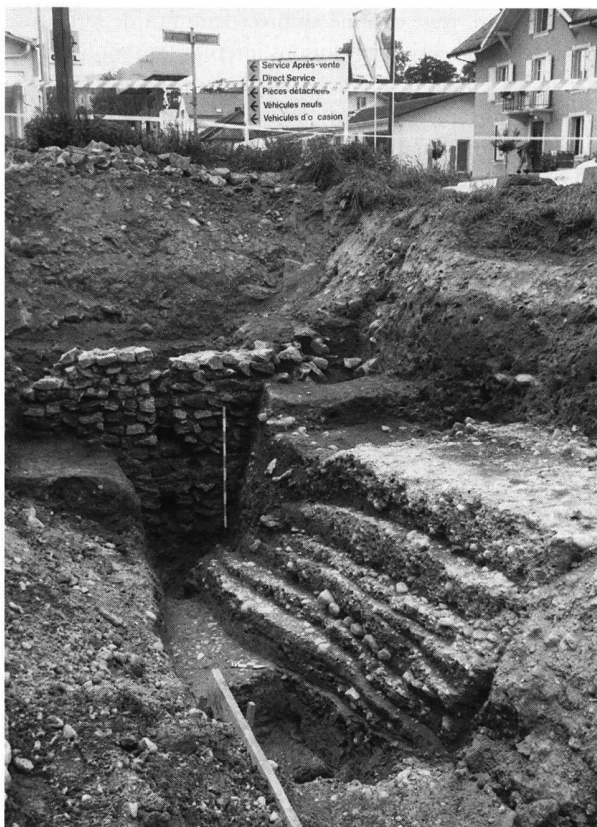
Fig. 23. Insulae 19/20, voirie, parement ouest du grand collecteur maçonné bordant l'insula 19 où apparaissent les négatifs des éléments verticaux et horizontaux du coffrage de construction. Au premier plan, mise en évidence de la stratification caractéristique de la rue (cardo 19/20).
