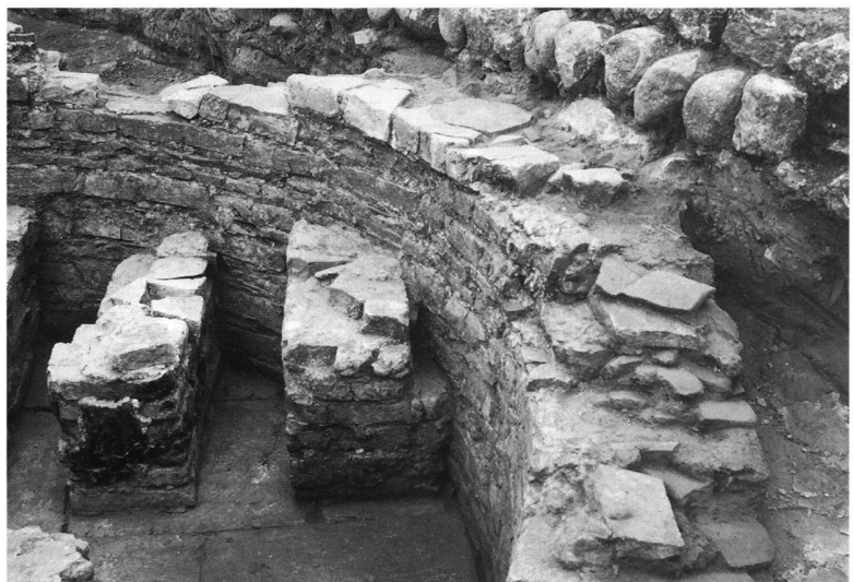
Fig. 12. Faubourgs Nord-Est. Four de tuilier Sud (1963). Vue de détail (parement interne de la chambre de chauffe, murets et conduits de chaleur).
