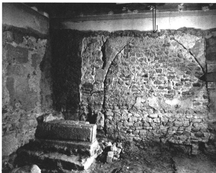
Fig. 18. Avenches / Rue Centrale 31. L'arc dans le mur mitoyen à l'angle nord-est de la maison. au premier plan sa base, partiellement conservée, avec un bloc de calcaire taillé en bossage. (Photo R. Gindroz, Lausanne).
