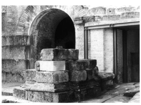
Fig. 15. Avenches, Amphithéâtre. Le piédroit sud de l'arc central du portail en grand appareil. Derrière, l'un des pilastres maçonnés encadrant le passage axial au travers du mur semi-circulaire du Rafour, dans son état reconstitué.
