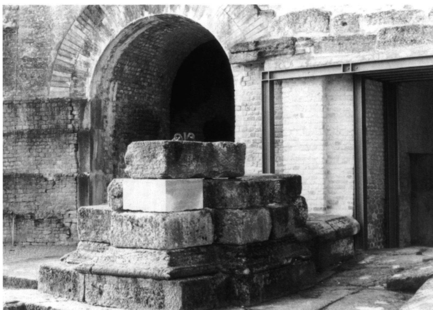
Fig. 15. Avenches, Amphithéâtre. Le piédroit sud de l'arc central du portail en grand appareil. Derrière, l'un des pilastres maçonnés encadrant le passage axial au travers du mur semi-circulaire du Rafour, dans son état reconstitué.
